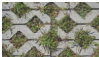
Figura 4: esempio di grigliato in cls inerbito
